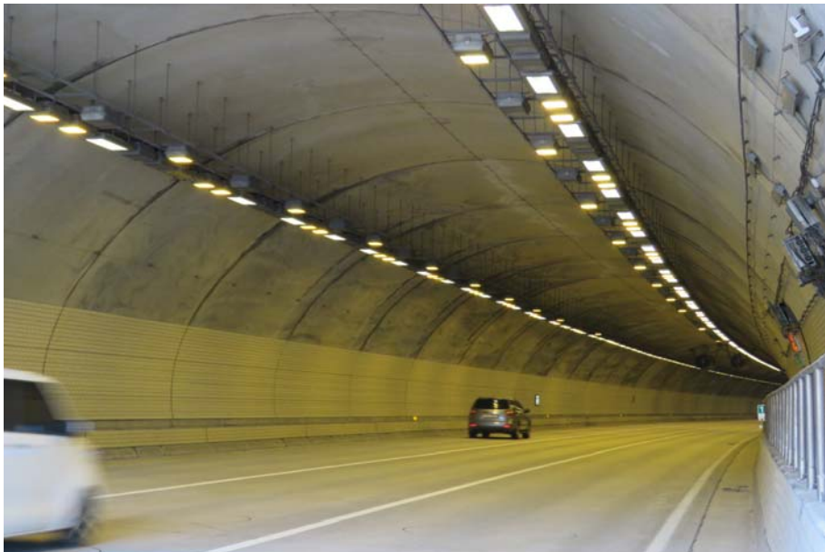
월문1터널(서울) 내부 전경
