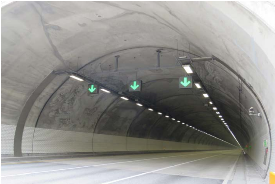
월문3터널(양양) 내부 전경
