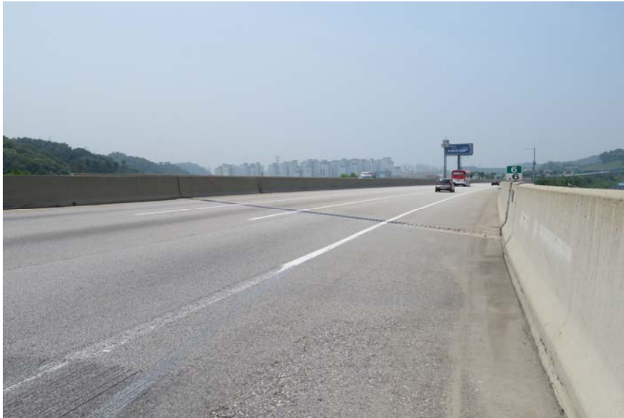
월문3교(서울) 상부 전경
