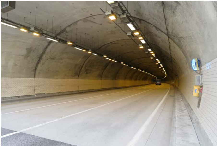
월문3터널(서울) 내부 전경
