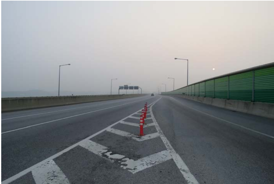
미사대교(양양) 상부 전경
