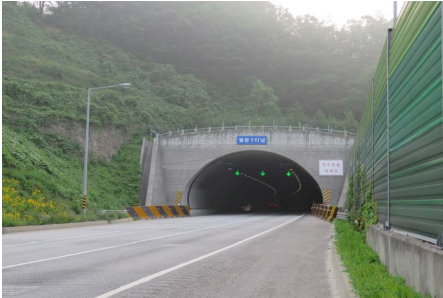
월문1터널(양양) 외부 전경
