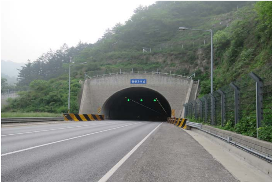
월문3터널(양양) 외부 전경
